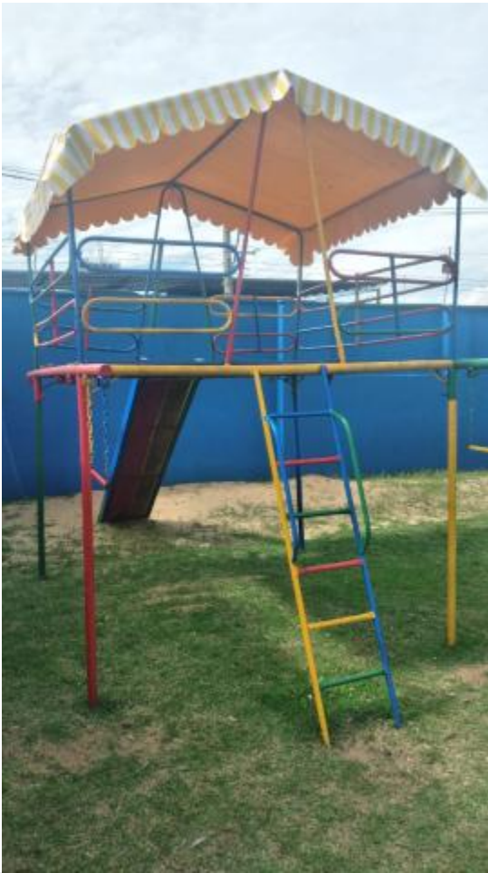
Colocação de lona na casinha do tarzan
