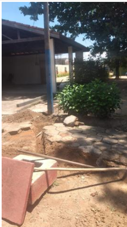
Restauração da cerca da área verde e retirada das vigas de concreto
